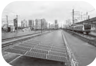
大規模太陽光発電/京葉車両センター 年間削減電力量:948MWh 年間削減CO 2 :470t
